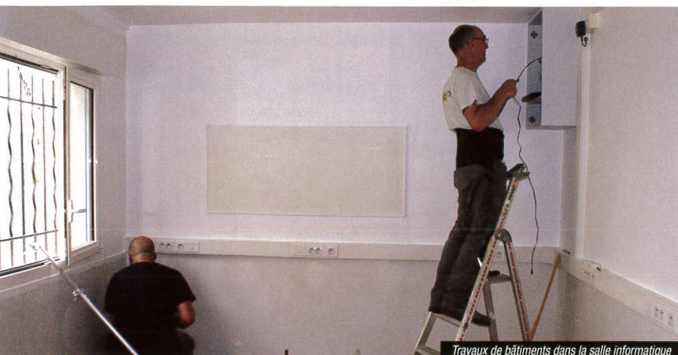
Travaux de bâtiments dans la salle informatique
